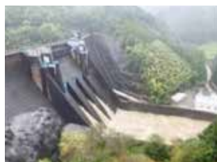
洪水調節状況
