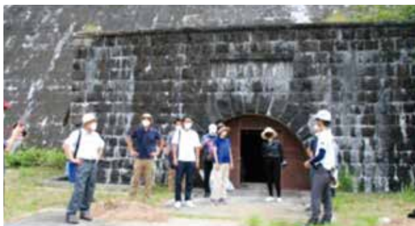
長崎の視察実施状況(本河内低部ダム)
