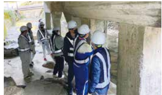
橋梁現場実習の様子
