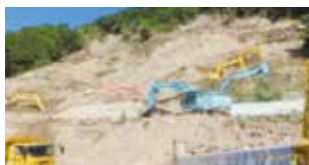
応急復旧工事状況
