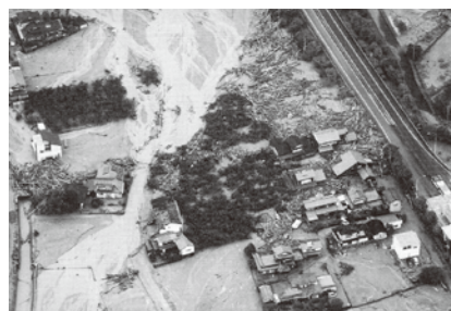
人家を襲った流木(右が大分道)福岡県・朝倉市、平成29年7月
