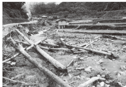
洪水と流木は道路を破壊した(東峰村)
