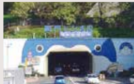
関門国道トンネル (山口県下関市～福岡県北九州市)
