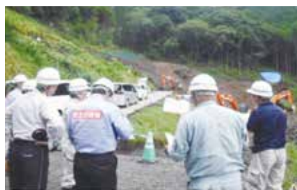
熊本復興事務所現場
