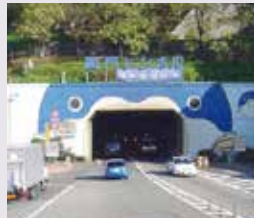
関門国道トンネル (山口県下関市～福岡県北九州市)
