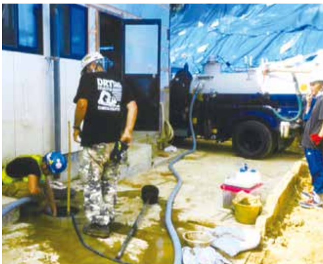
バキューム車による土砂水吸入
