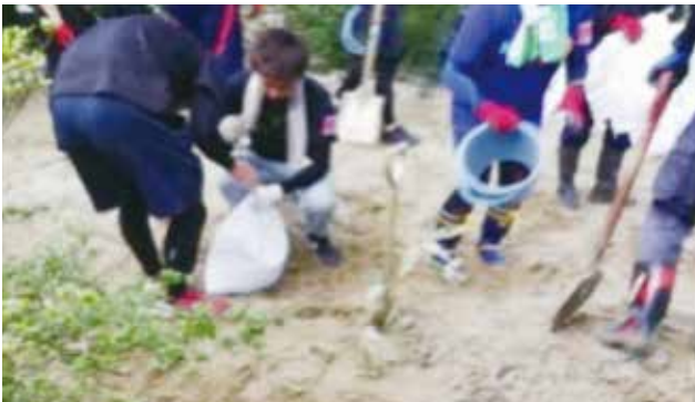
土のうによる土砂撤去作業
