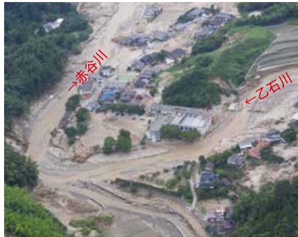
H29.7(朝倉市)被災直後 赤谷川・乙石川合流点
