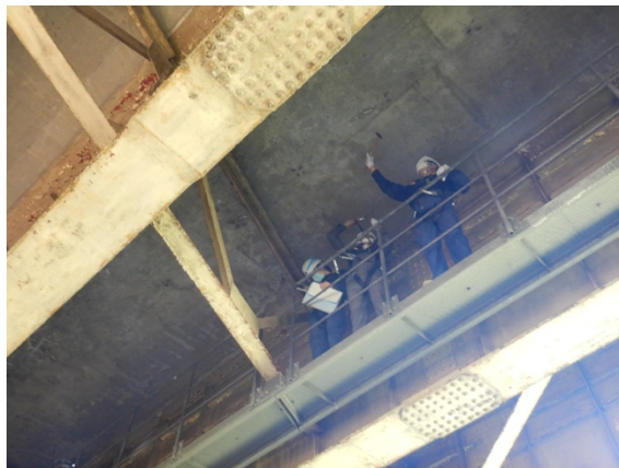
写真2 橋梁点検実習状況
