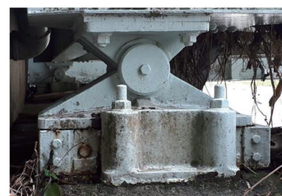
(b) アンカーボルト（長締め）
