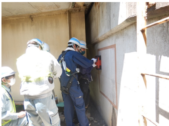
写真3 非破壊試験機による調査実習
