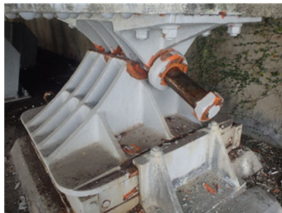
図-2 ピン抜け出し
