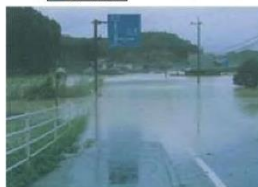
ふもと ②宮崎市高岡町 麓 主要道日南高岡線 大淀川右岸 18k000
