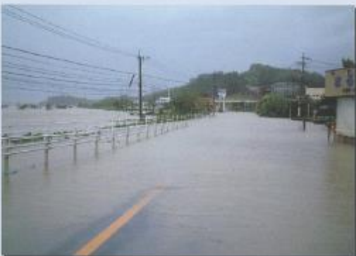
宮崎市上北方 県道26号 大淀川左岸(9k800)
