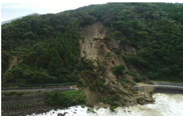
宮崎220号日南市宮浦の斜面崩壊状況
