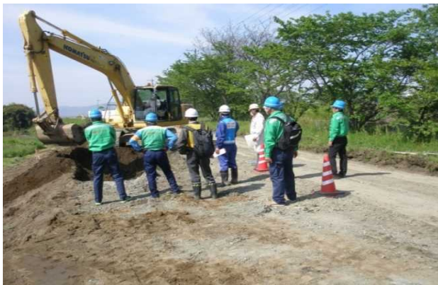
現地での支援(クラック状況調査)
