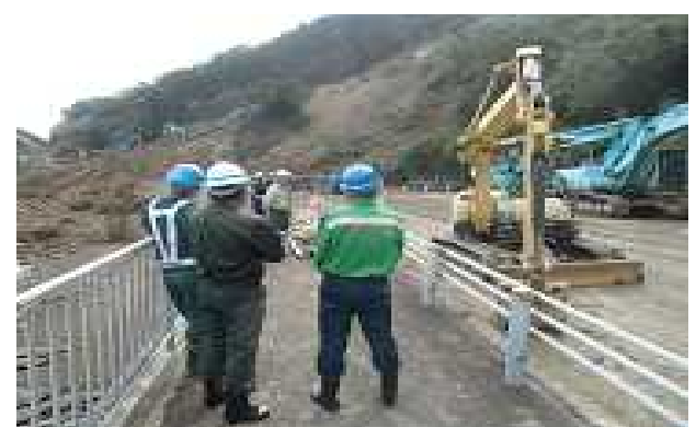
斜面災害復旧工事の監督支援
